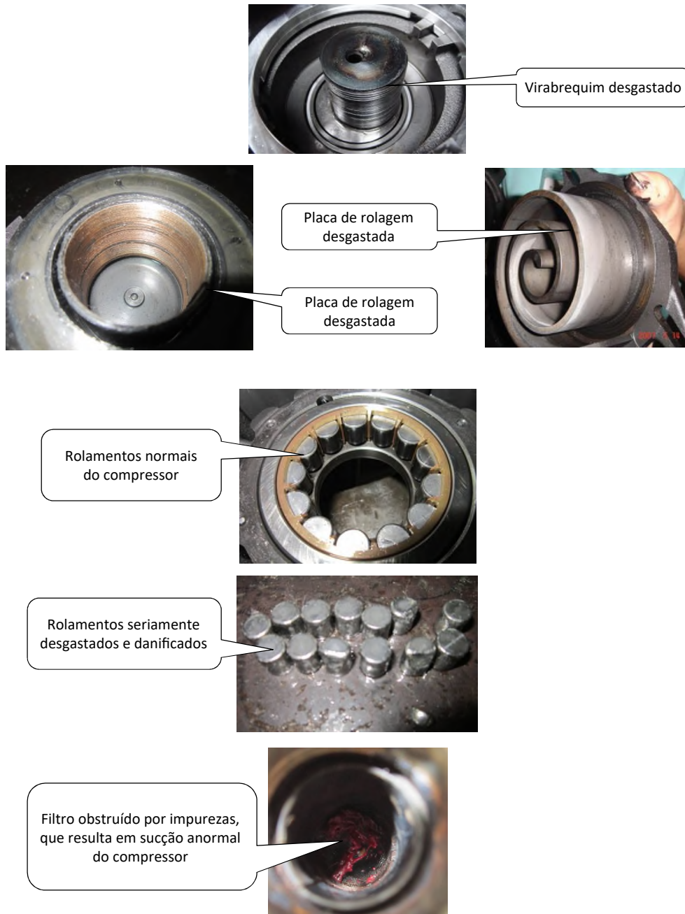
Figura 64: Efeitos do óleo deteriorado do compressor
